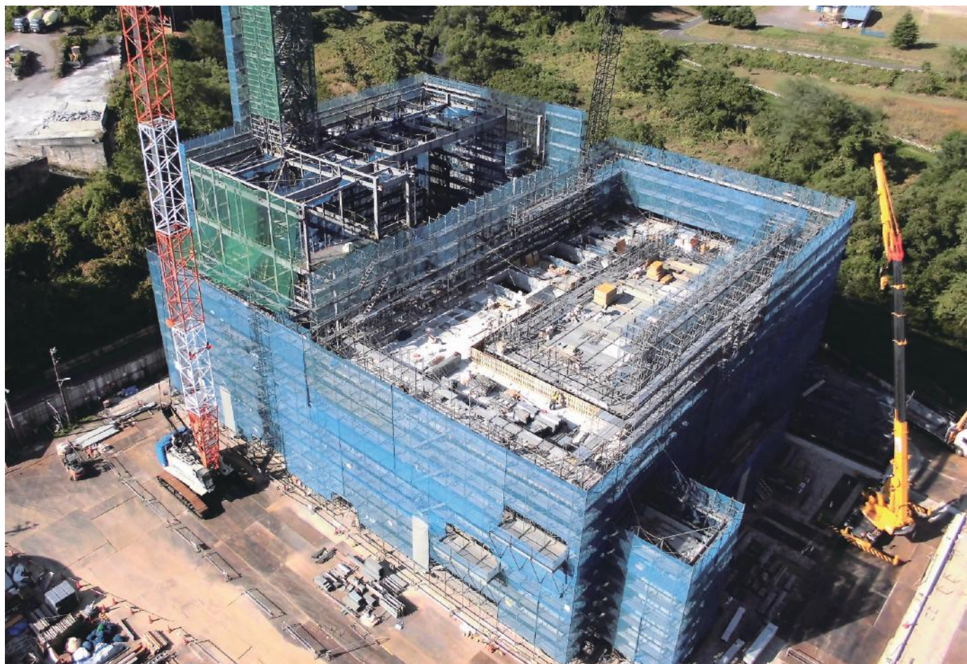
新ごみ処理施設の建設現場(平成29年10月下旬)
