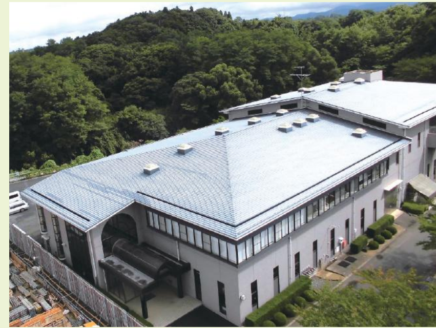
し尿処理施設は、構成市町村の各家庭からバキュームカーで汲み取られた「し尿」や「浄化槽汚泥」を処理している施設です。 (1日あたり97kℓ)
