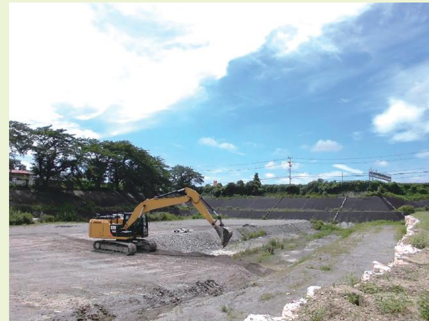
埋立処理施設は、構成市町村から収集された、主に可燃ごみを焼却した後の焼却灰と、食器などの再生利用ができない不燃ごみを埋立処理している施設です。また、雨水が埋立処理施設にしみこむことで出てくる、排水(浸出水)を安全に放流するために、排水処理を行っています。
