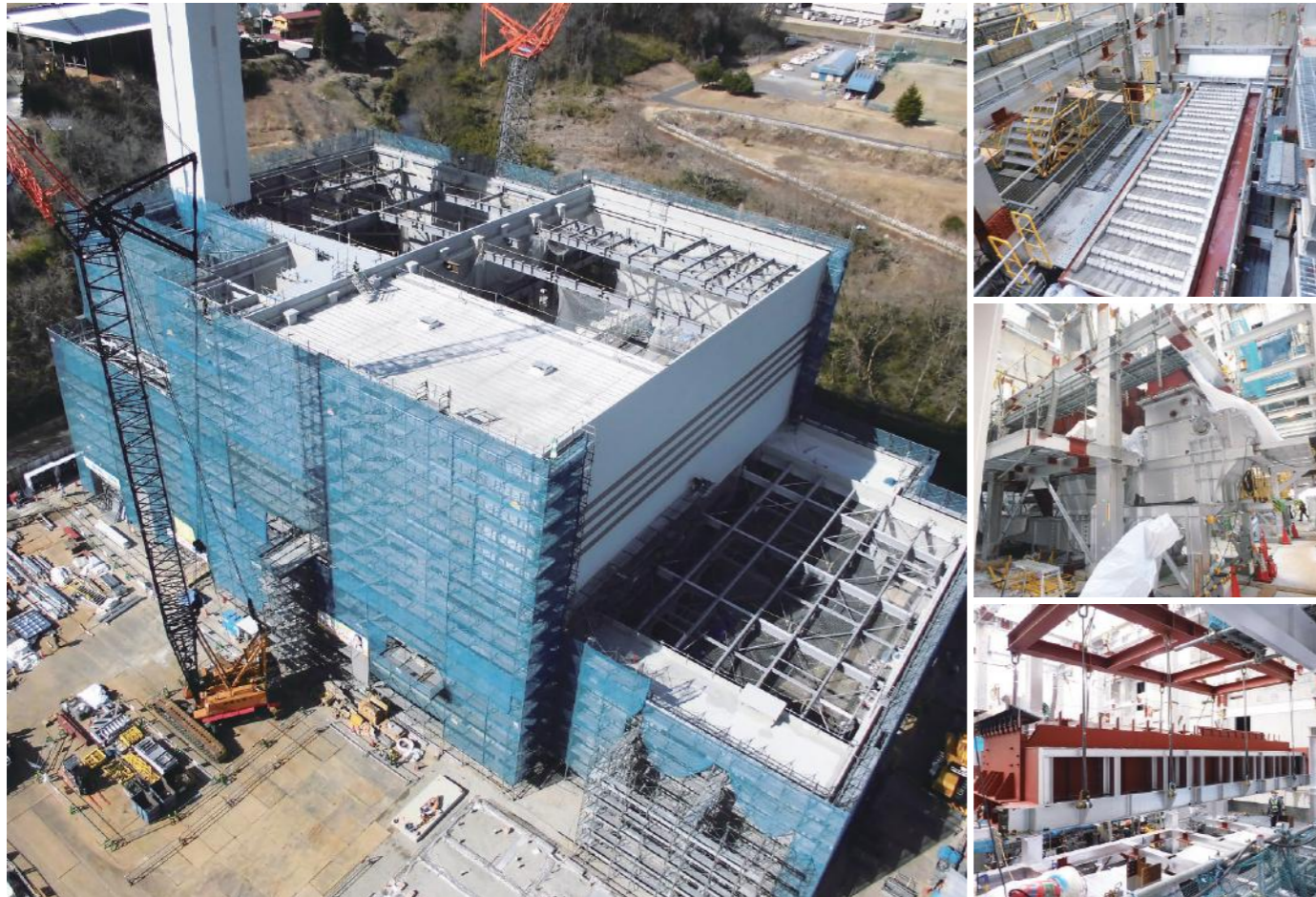
新ごみ処理施設の建設現場(平成30年3月上旬)
