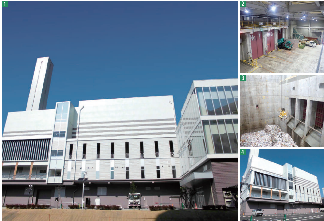
1 新ごみ処理施設完成写真 2 プラットホーム 3 ごみピット 4 新ごみ処理施設工場棟 (平成31年2月下旬)
